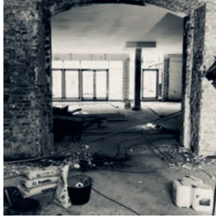
Vor dem Umbau im August 2020
